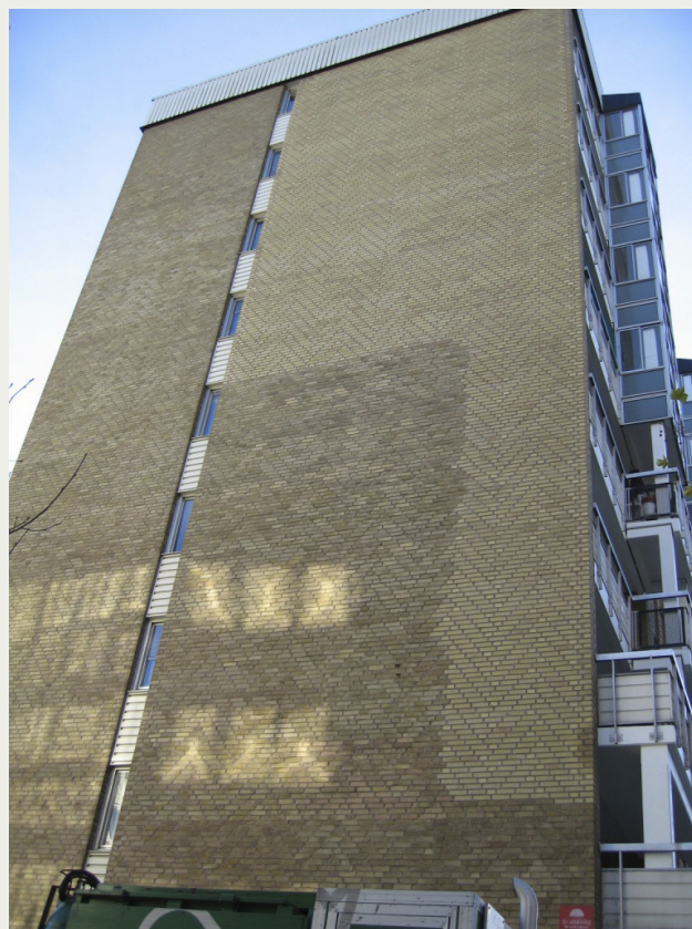
Bild 2. Återuppmurad gavelvägg efter fasadras på 1980-talet, Rosengård, Malmö.
