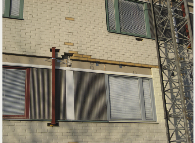
Bild 4. Stämning av 5.4 meter lång muröppning, Parentesen, Lund.
