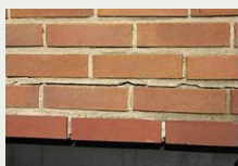
Bild 1. Spricka orsakad av korroderande horisontalarmering.
